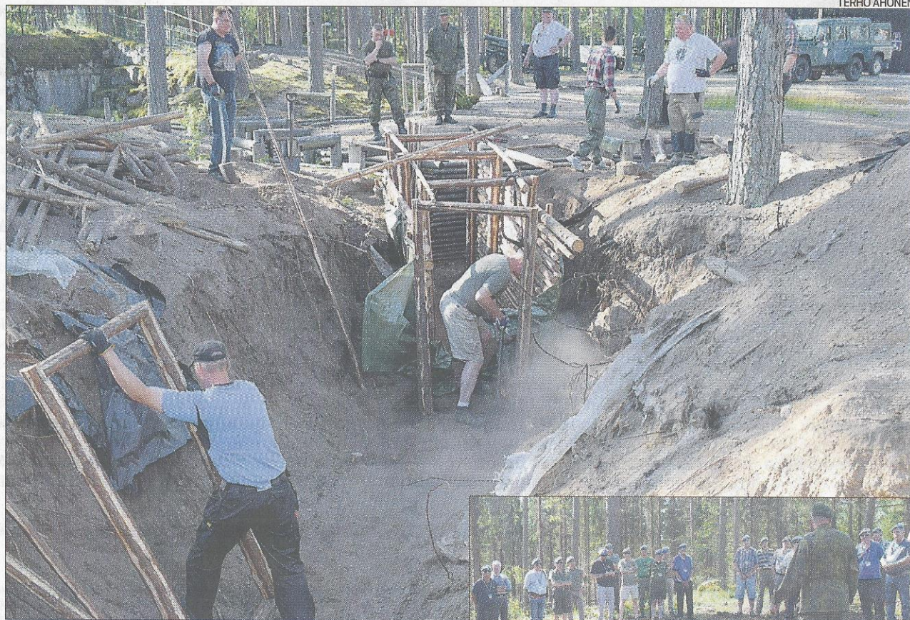
Virolahden Bunkkerimuseolla työtä vaikeutti vanhan puuverhoilun poistaminen yhteyshaudasta ja laukeava hiekkamaa.
